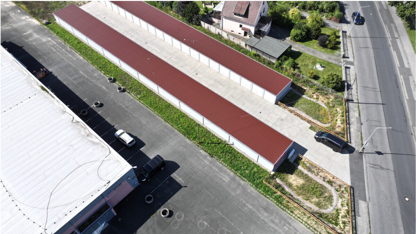
Garagenhof Neustadt bei Coburg
