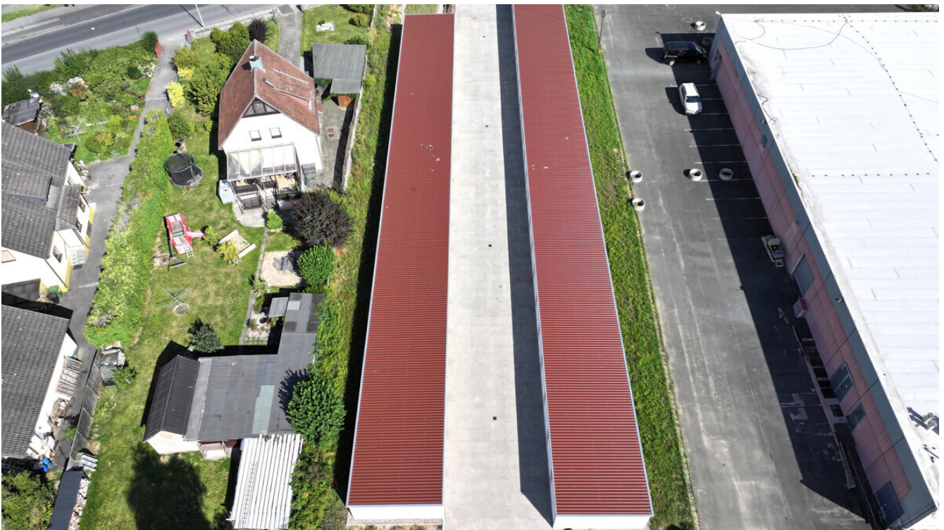
Garagenhof Neustadt bei Coburg
