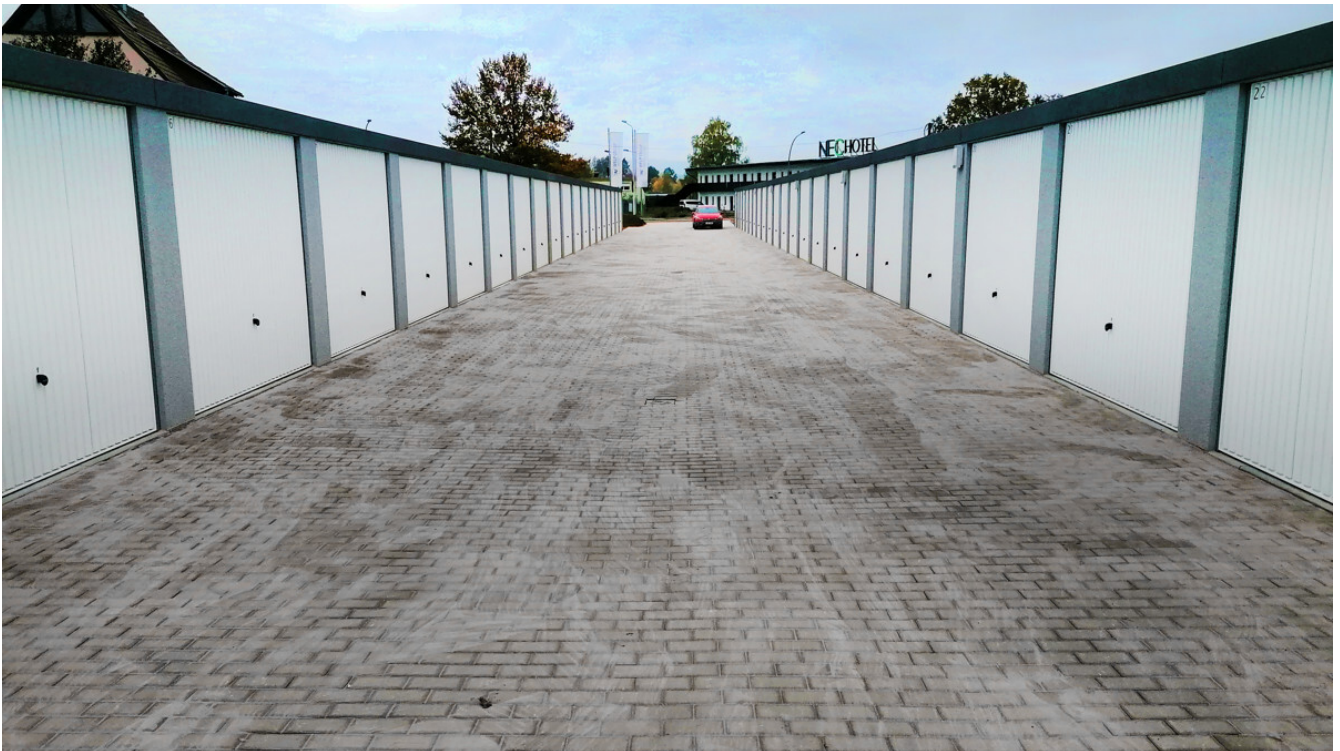
Garagenhof Neustadt bei Coburg
