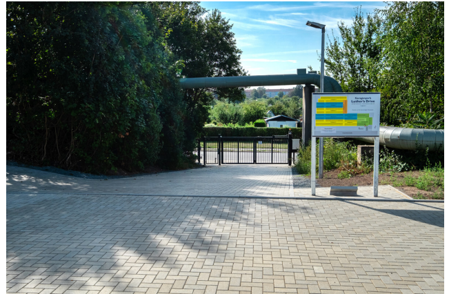
Zufahrt Garagenpark Chemnitz
