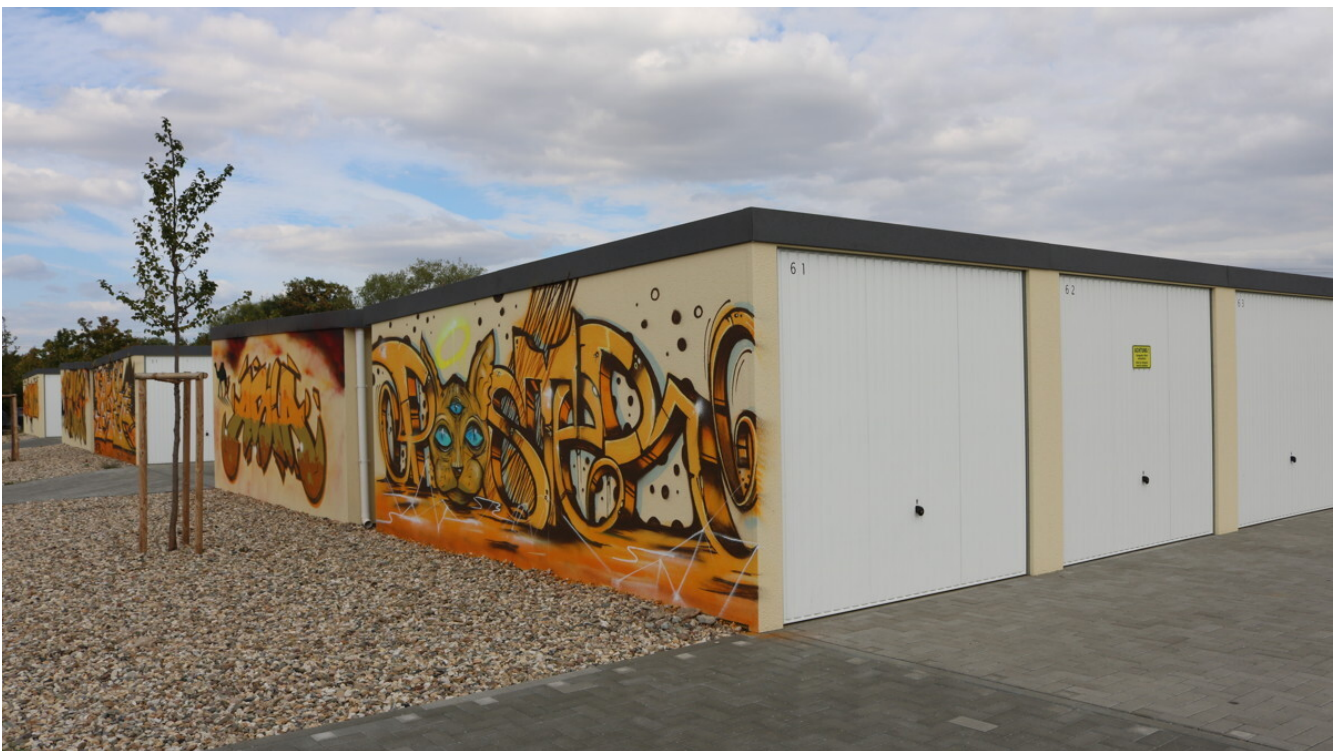
Kabelsketal, AM Beuditzer Weg
