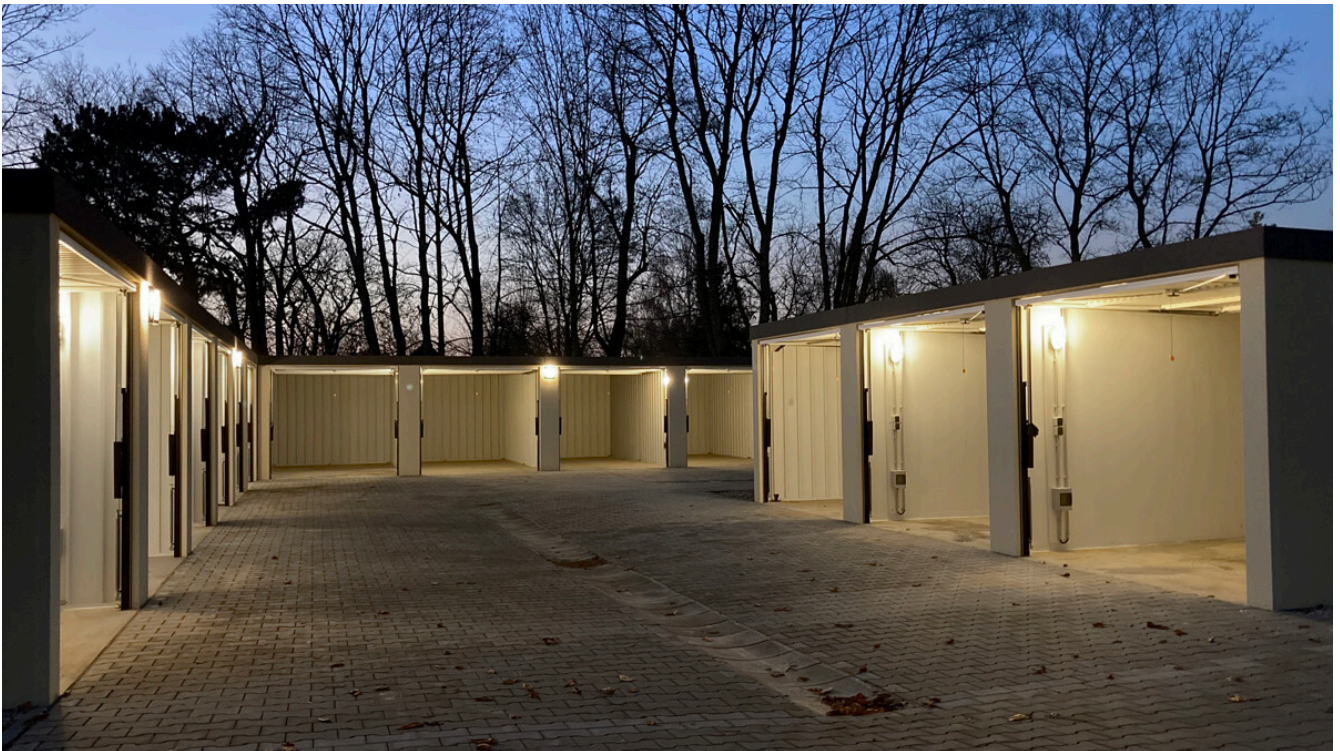
Kabelsketal, AM Beuditzer Weg
