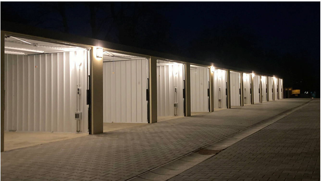
Kabelsketal, AM Beuditzer Weg
