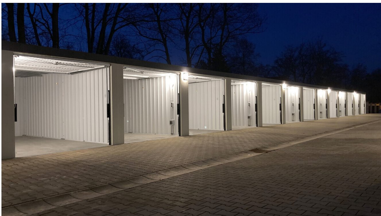
Beispiel Garagenreihe mit Beleuchtung
