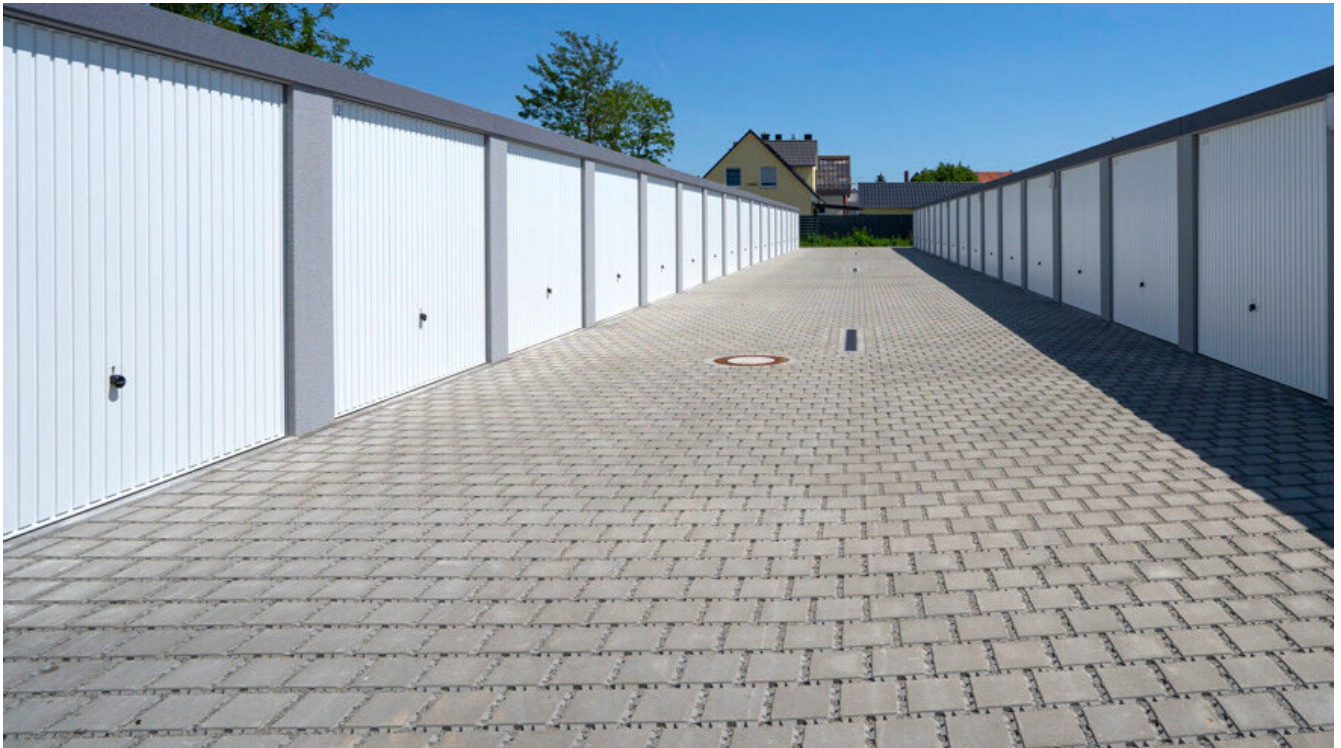
Beispiel Neubau Garagenhof
