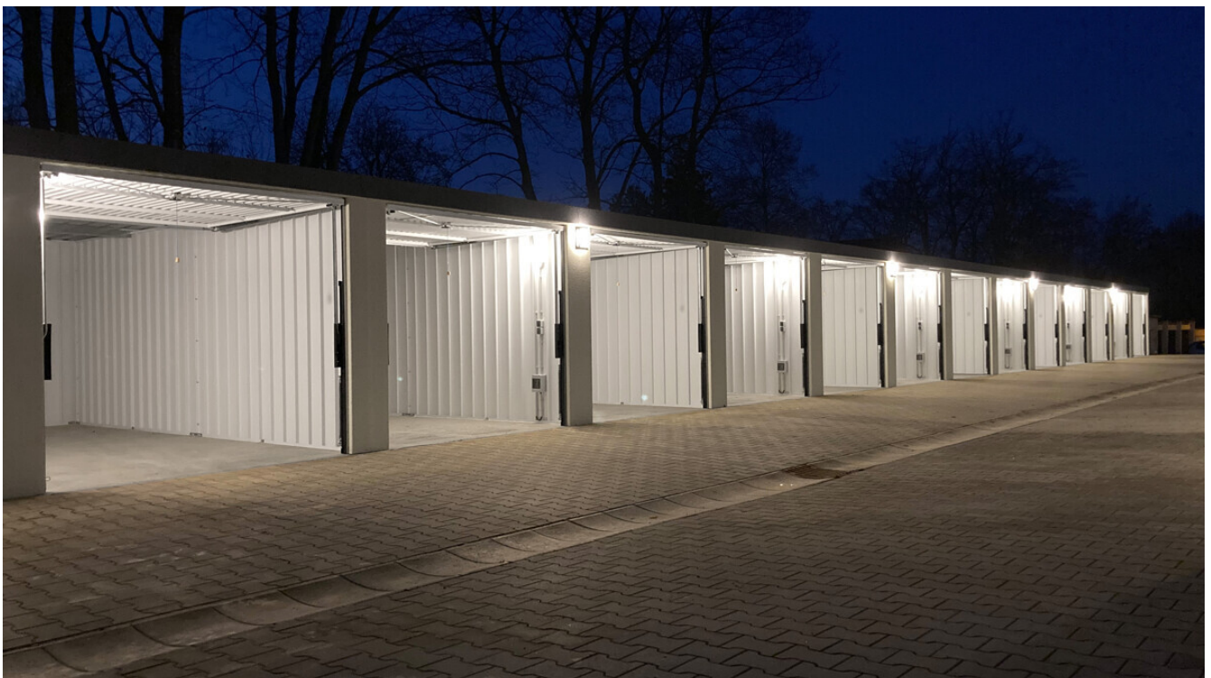
Beispiel Garagenreihe mit Beleuchtung
