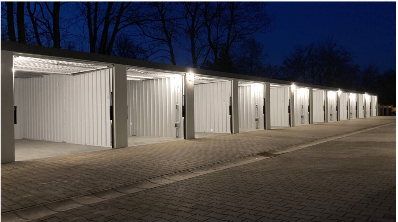
Beispiel Garagenreihe mit Beleuchtung
