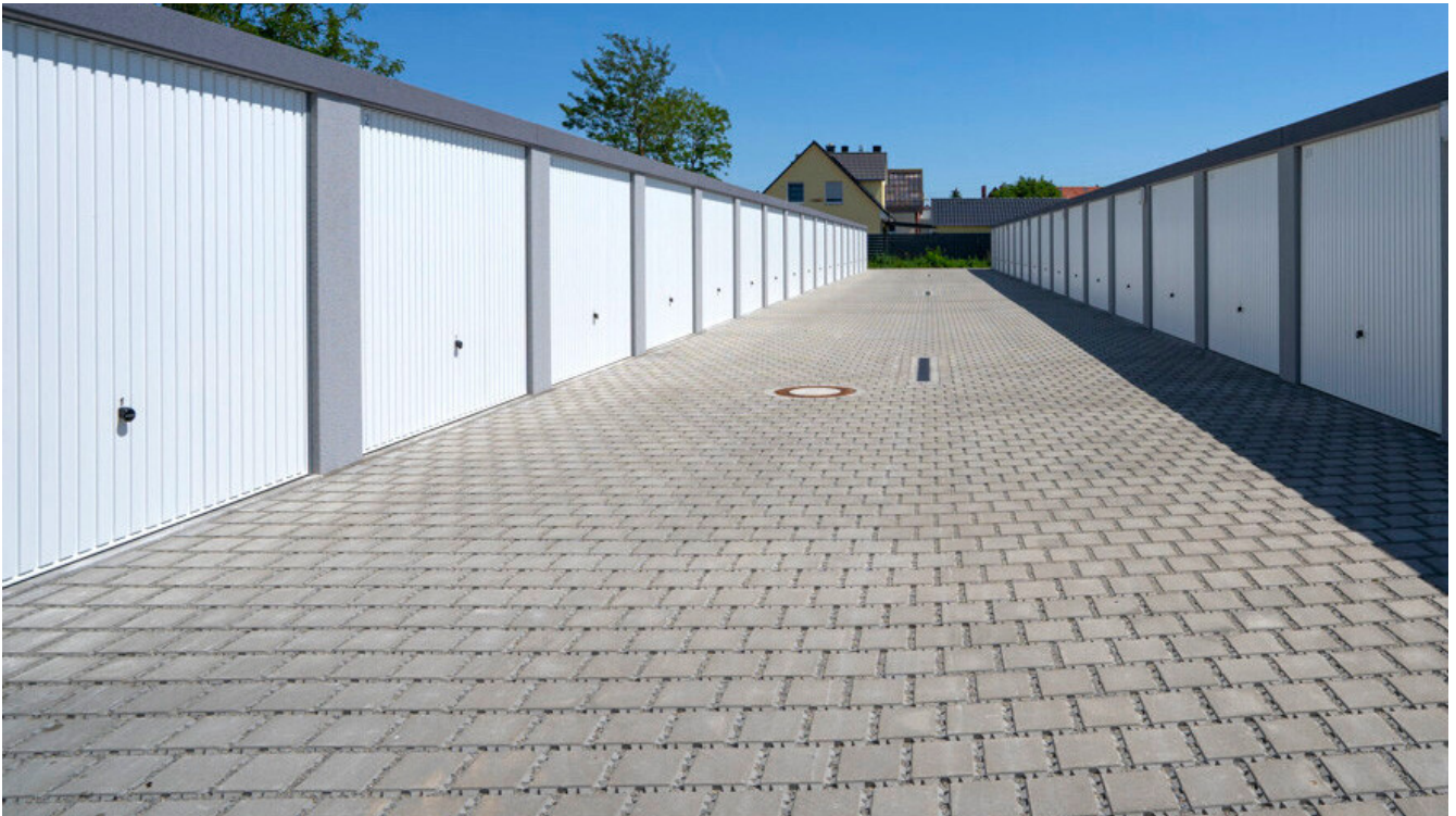
Beispiel Neubau Garagenhof
