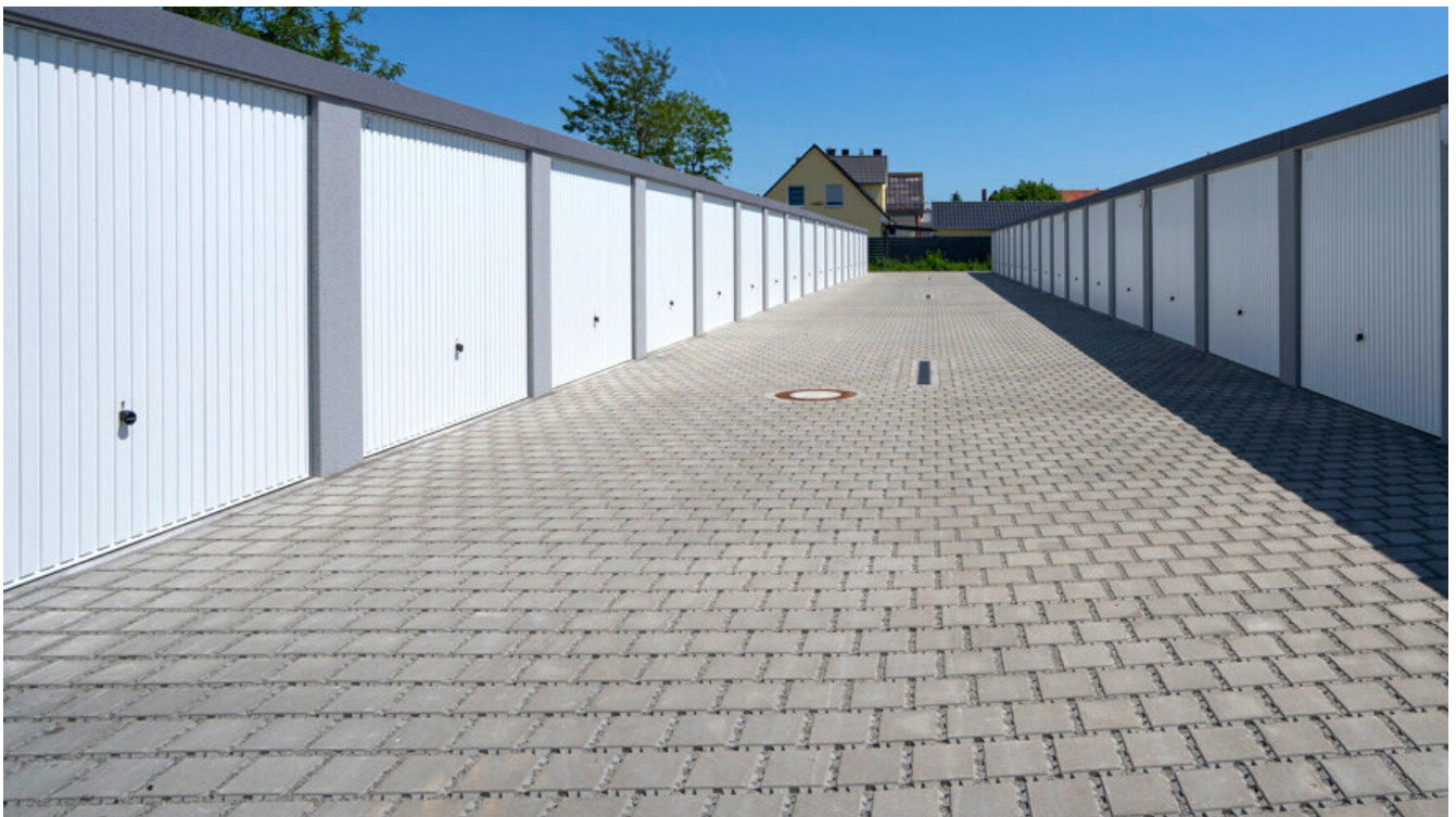
Beispiel Neubau Garagenhof
