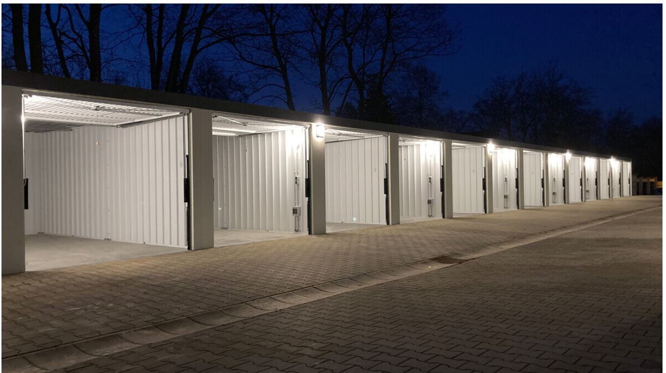
Beispiel Garagenreihe mit Beleuchtung
