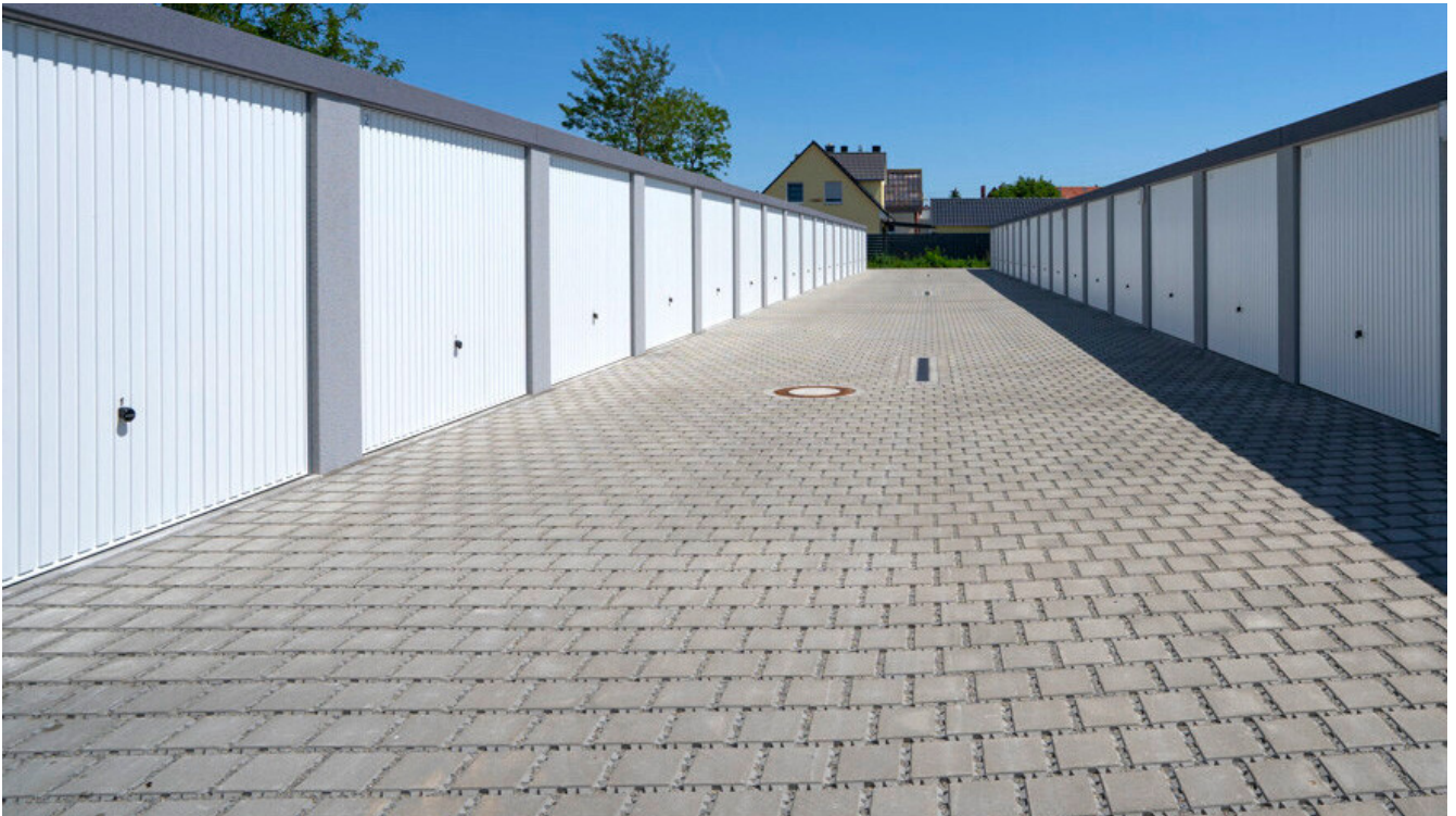
Beispiel Neubau Garagenhof
