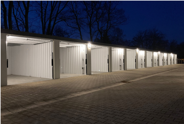
Beispiel Garagenreihe mit Beleuchtung
