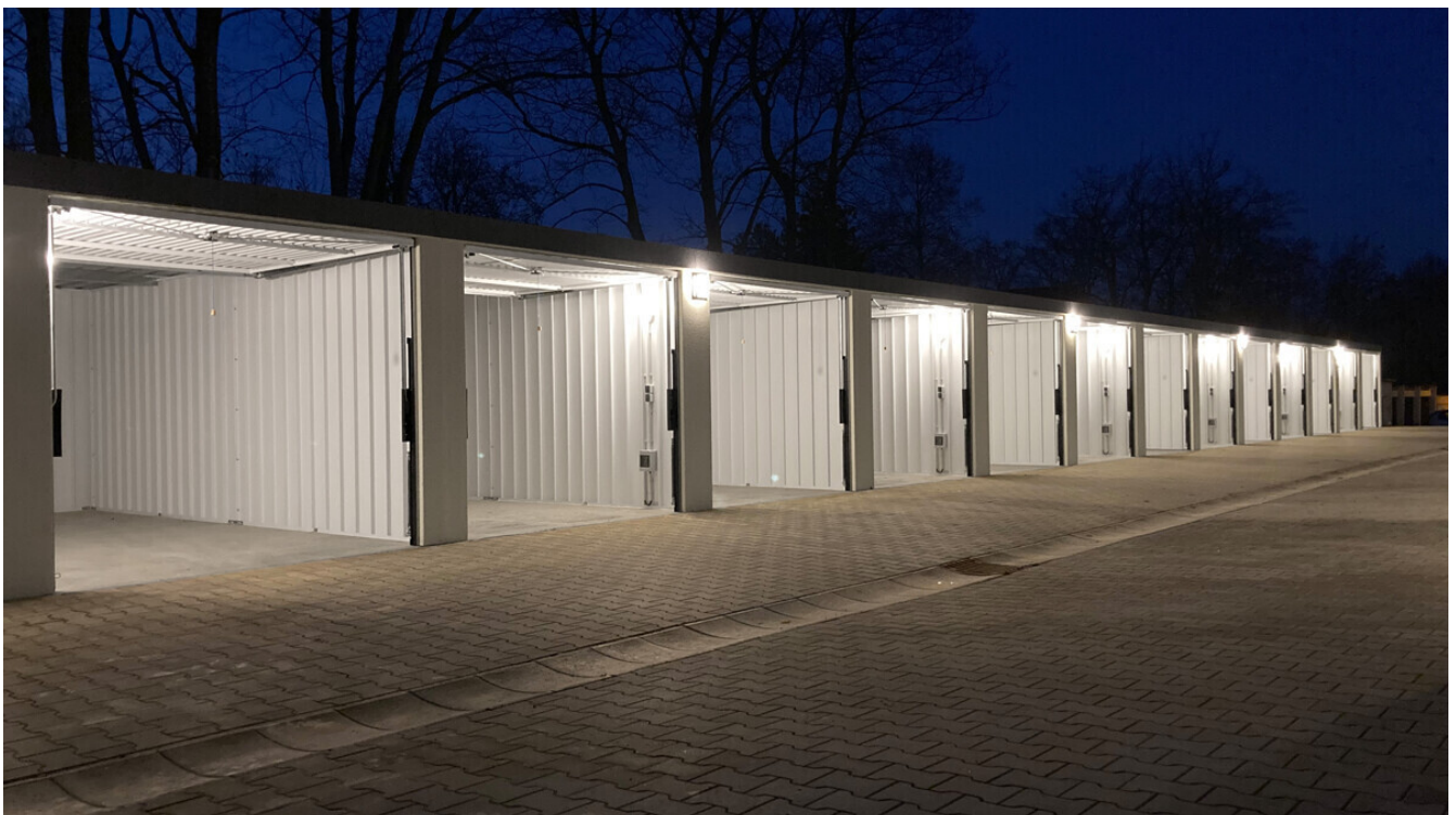
Beispiel Garagenreihe mit Beleuchtung
