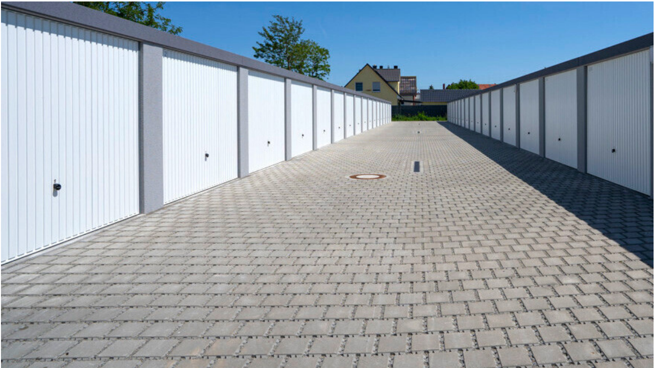
Beispiel Neubau Garagenhof
