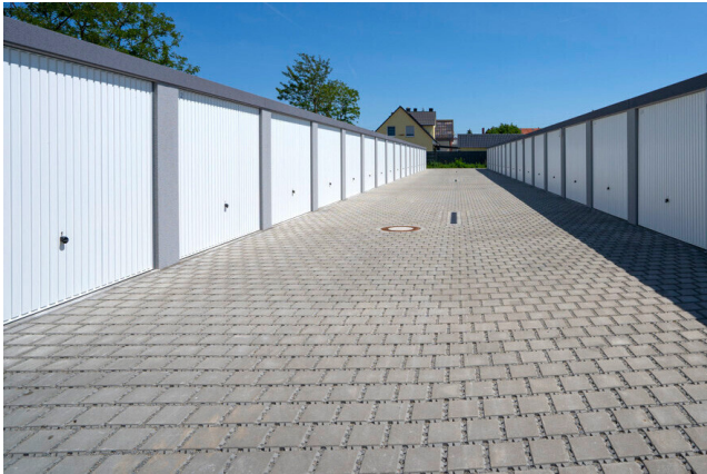
Beispiel Neubau Garagenhof
