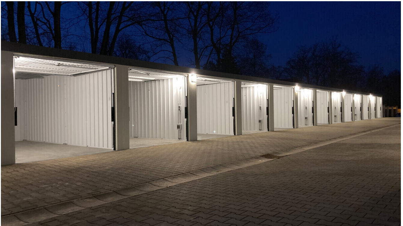
Beispiel Garagenreihe mit Beleuchtung
