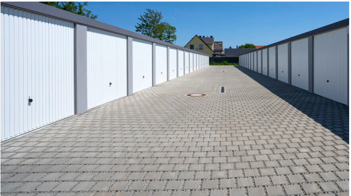
Beispiel Neubau Garagenhof
