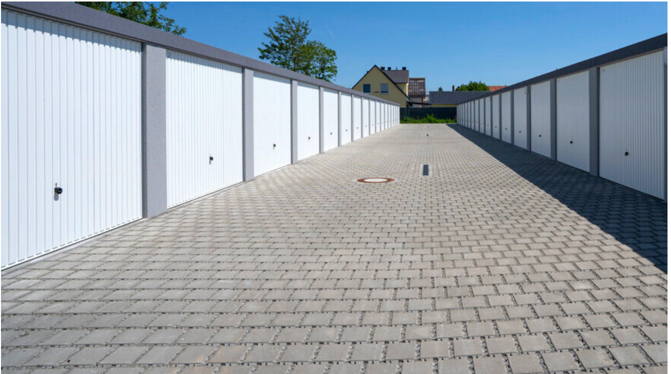
Beispiel Neubau Garagenhof
