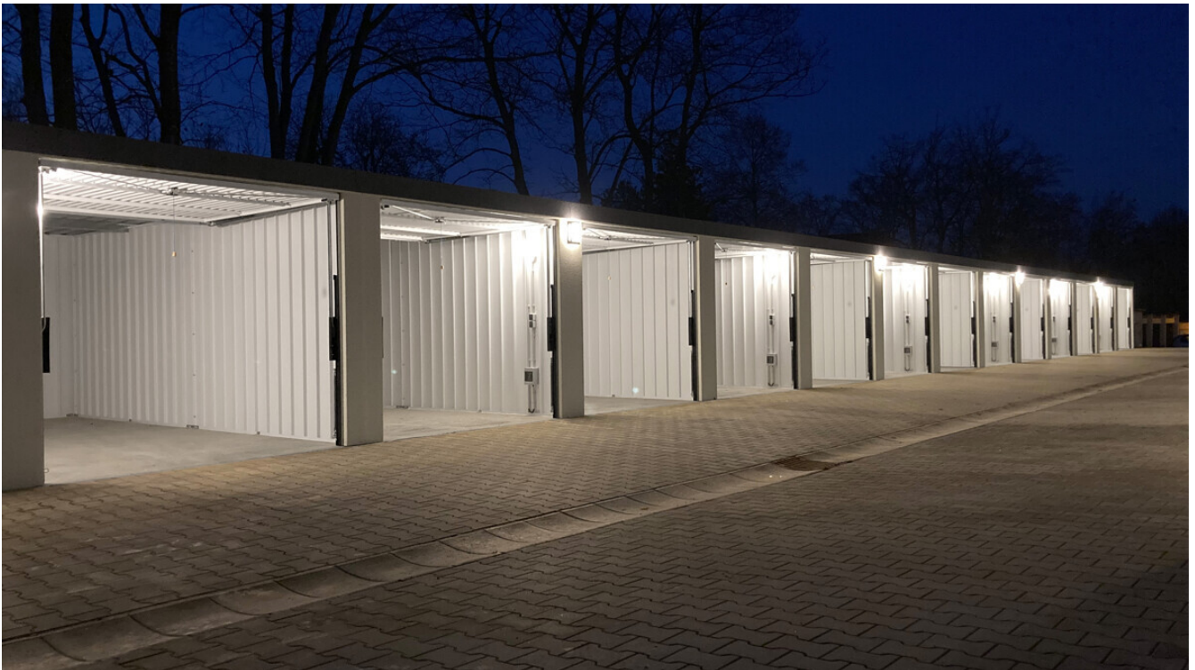
Beispiel Garagenreihe mit Beleuchtung
