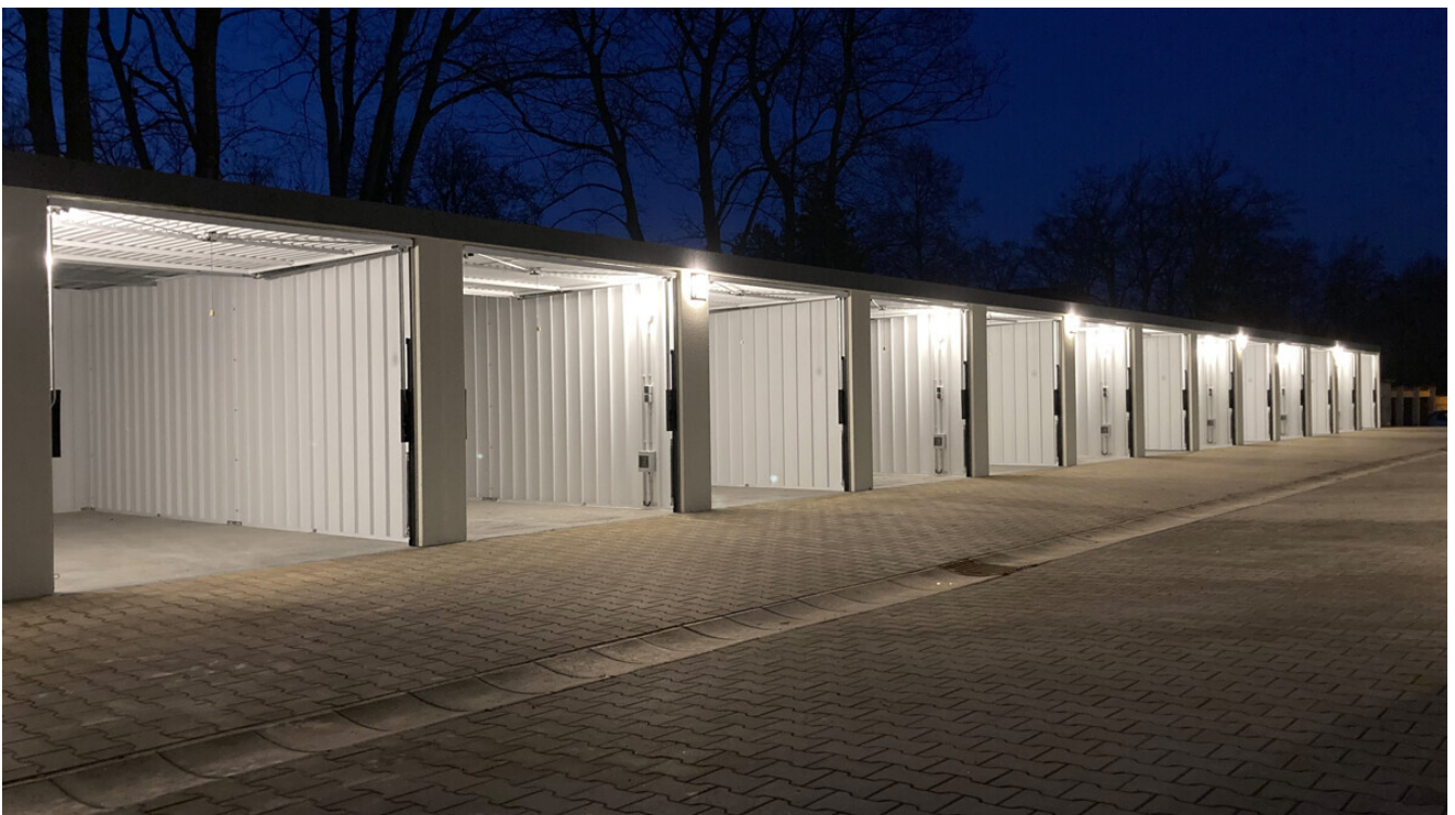
Beispiel Garagenreihe mit Beleuchtung
