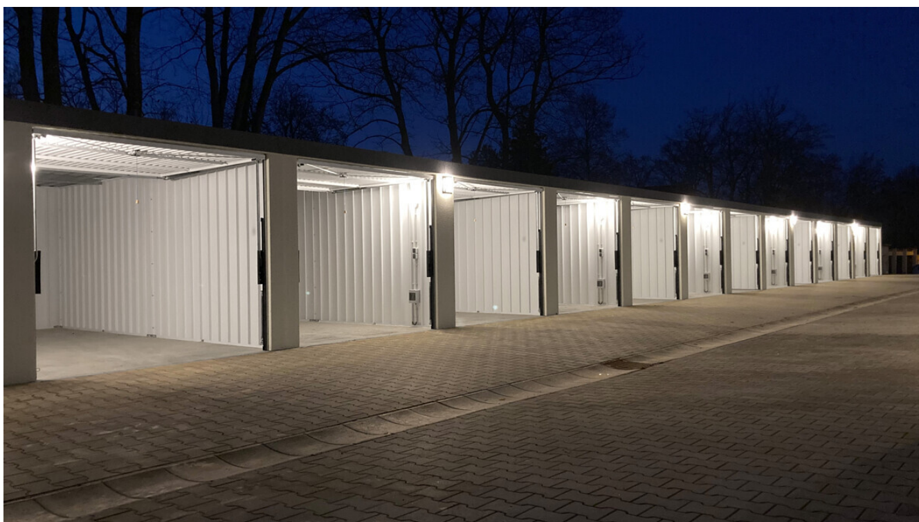
Beispiel Garagenreihe mit Beleuchtung
