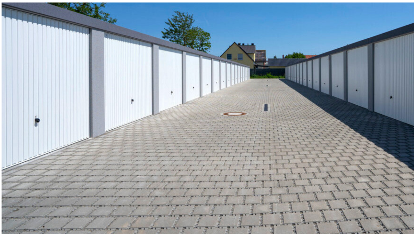
Beispiel Neubau Garagenhof
