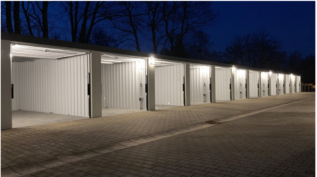
Beispiel Garagenreihe mit Beleuchtung
