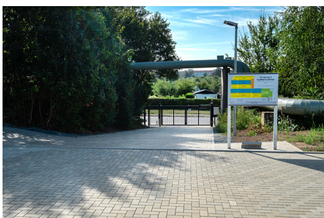
Zufahrt Garagenpark Chemnitz
