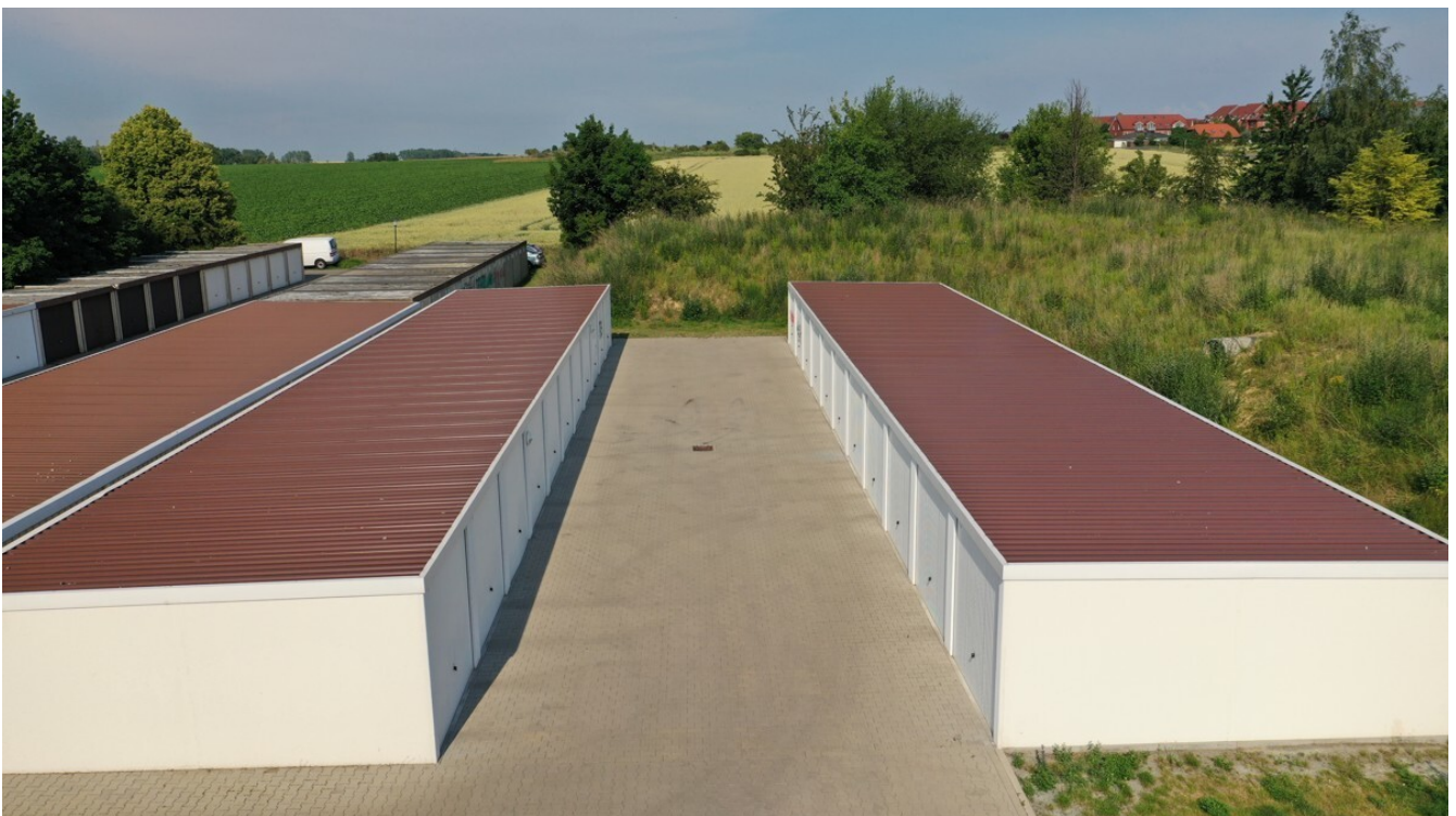
Garagenhof Groß SanTERSleben
